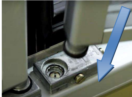
Insert Torque Rod
