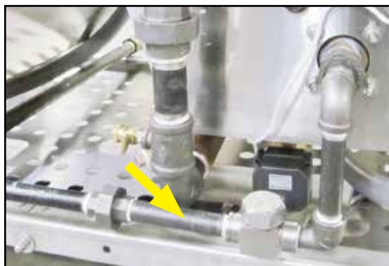
Fig. 11 - Condensate return.
