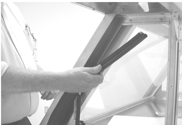
Replace rubber gasket on pylon.
