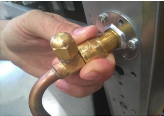
Image 4: Filetez les raccords à la main
