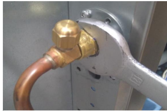
Image 4 : Serrez avec une clé fixe dans le sens des aiguilles d'une montre
