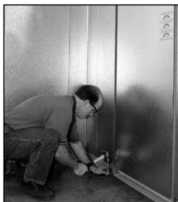
Instale el anclaje
