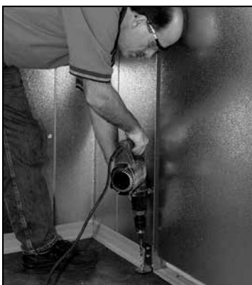
El tamaño de agujero recomendado para el sistema PARABOLT ANCHOR es 3/8" X 2-1/4"
