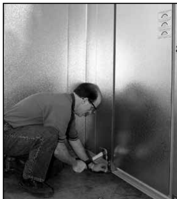
Instale el anclaje
