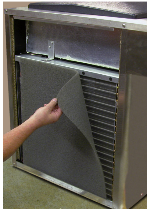
Figure 3-11 F112 Enlèvement du Filtre du Condenseur
