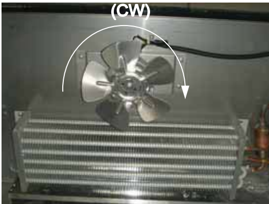
EVAPORATOR FAN MOTOR (TCBE-52SDR)
