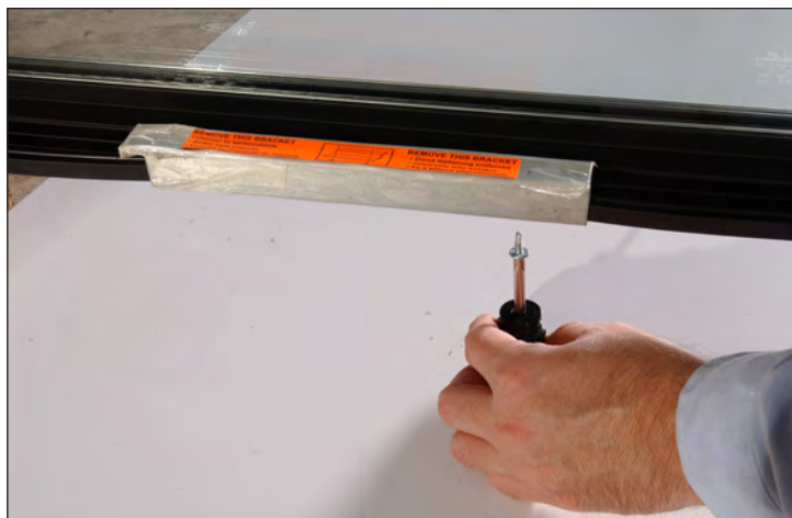
Fig. 2. No retire los soportes de transporte hasta que la unidad esté en su ubicación final.
